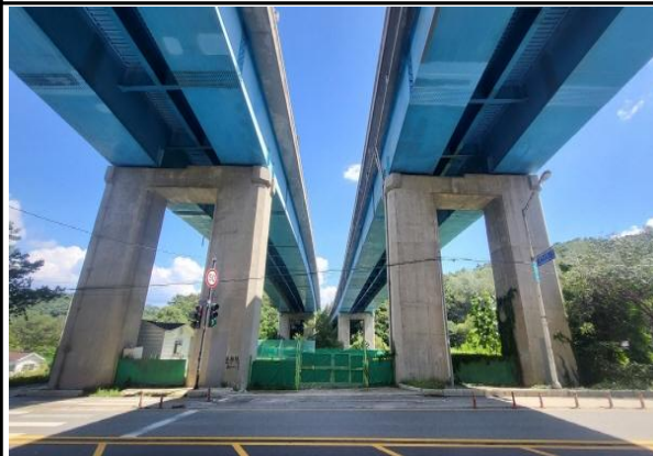
바닥판 및 거더, 가로보 전경
